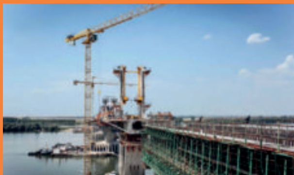
Το εργοτάξιο της δεύτερης γέφυρας στον Δούναβη μεταξύ Calafat (Ρουμανία) και Vidin (Βουλγαρία)
